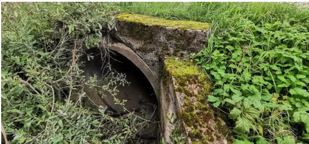
Foto 8. Vaade truubi T1 (Ø140 cm) sissevoolule. Truubis veevoolamist ei toimunud ja setet ei olnud.
