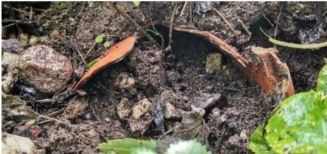
Foto 7. Vaade truubi T2 (Ø10 cm, plasttoru) sissevoolule. Truup pinnast täis ja toru ots katki.
